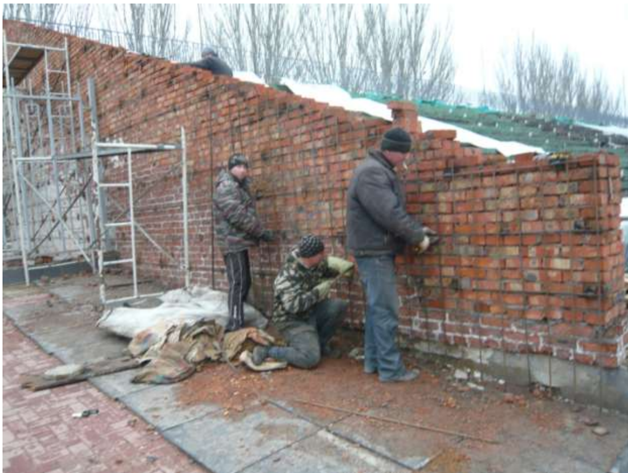
Ремонт торцевой стены трибуны
