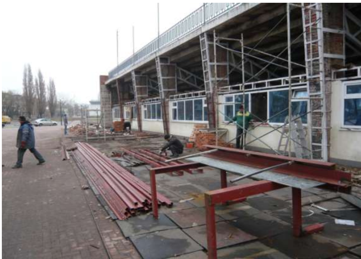
Ремонт лицевой стороны трибуны
